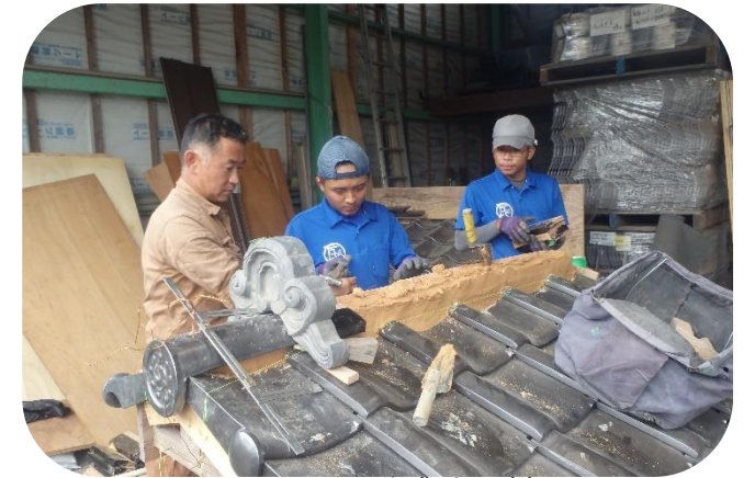
作業中の様子
