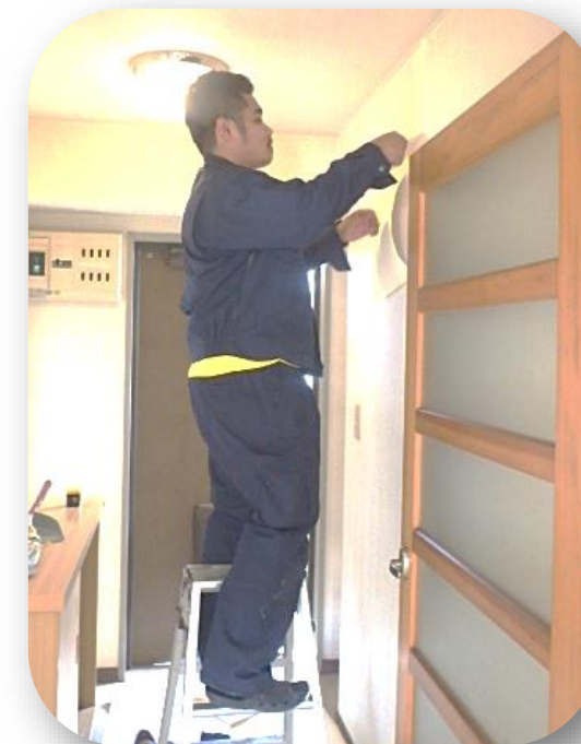
内装クロス張り
