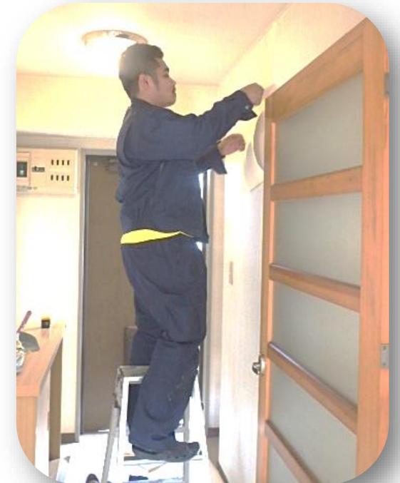
内装クロス張り
