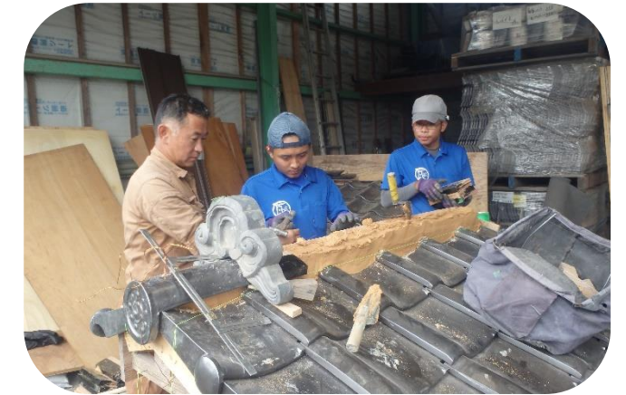
作業中の様子
