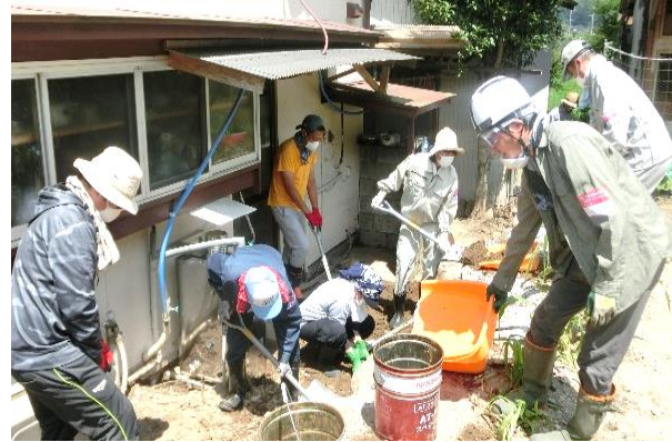
家屋に流れ込んだ土砂の撤去作業→
